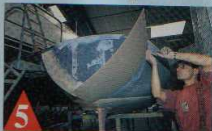
5 Il faut impérativement poser les plaques dans le prolongement des lignes de la carène.
