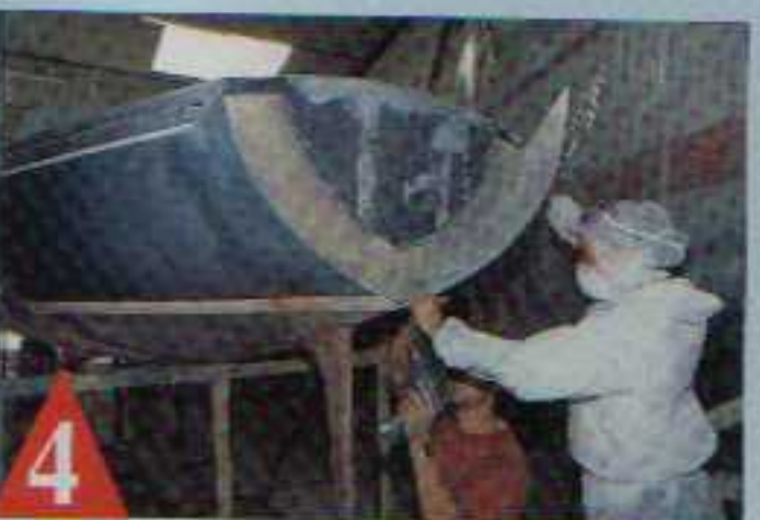
4 Les plaques sont directement percées et vissées dans la coque pour épouser ses formes.
