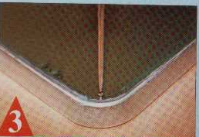
3 Avant de mettre en place les vis et les serrer, il faut aussi enduire le filetage de silicone.
