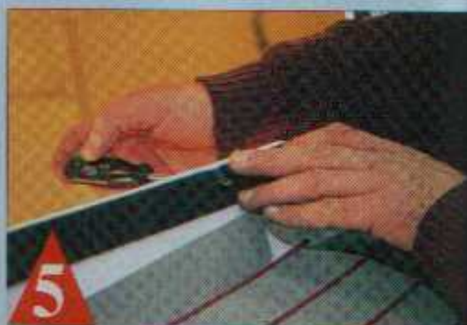
5 Les trente-sept trous de vis seront facilement percés avec un tournevis cruciforme.
