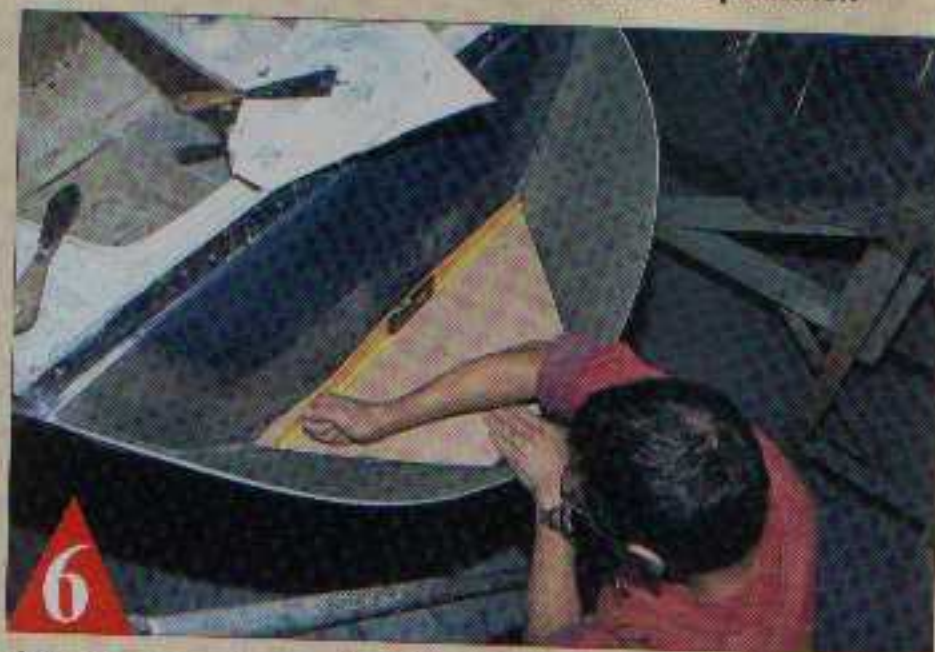
6 À l'aide d'un niveau à bulle, il faut vérifier que le plancher est bien parallèle à l'axe horizontal du bateau.
