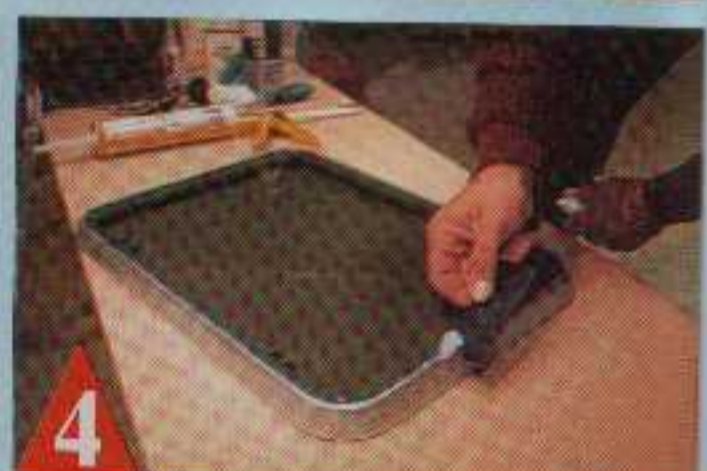
4 Le surplus de mastic est enlevé avec une spatule. Attention de ne pas rayer l'altuglas.
