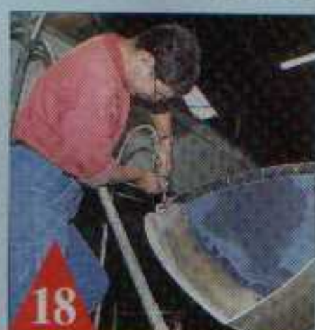
Les angles et reprises sur le tableau sont aussi ponçés.
