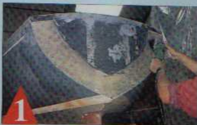
1 Le ponçage pour les reprises de stratification sur le tableau arrière est indispensable.
