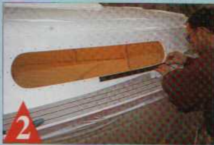
2 On pose le joint adhésif par le bas pour que le raccord se retrouve précisément en bas.
