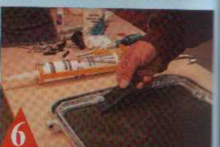
6 L'intérieur du panneau sera nettoyé de la même manière avant le séchage du silicone.
