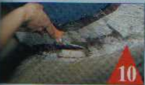
Grâce aux congés, la pose dans les angles est facilitée.
