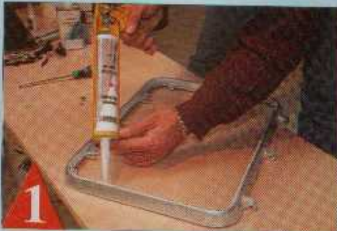
1 Une fois la remise à neuf de l'alu achevée, c'est avec du mastic silicone que l'on colle...
