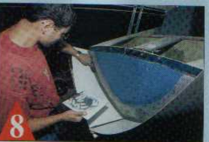
8 C'est à la choucroute que l'on fait des congés dans les angles pour faciliter la pose...
