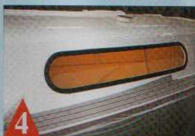
4 Une fois le tour achevé, il suffit de couper le joint à l'aide d'un cutter : c'est prêt !
