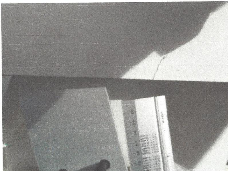
*Le réglelet métallique est en appui sur les parties haute et basse du fourreau, le prolongement du fourreau n'est pas dans le même plan !*
