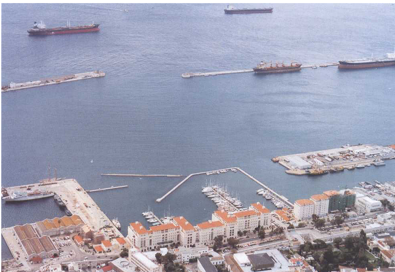
Vue vers l'ouest sur la marina Queensway Quay, depuis le minet au téléphérique, avec le brise-lames sud (pointe « A ») et le brise-lames séparé (pointe « B ») (en arrière-plan).
