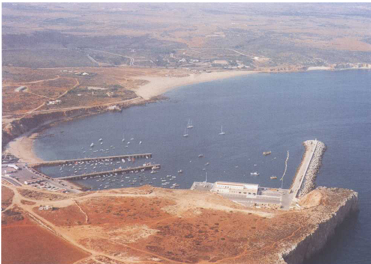
Le port de pêche de Baleeira, vu du sud, avec plusieurs voiliers au mouillage.
