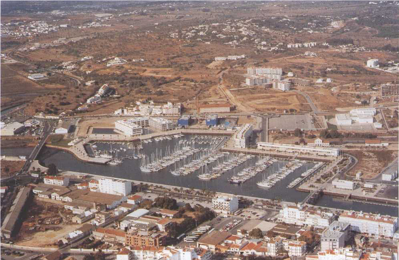
La marina de Lagos, en regardant vers le nord-est. Le ponton d'accueil et de carburant se distingue sur la droite, près du pont piétonnier et des bureaux blancs de la marina.
