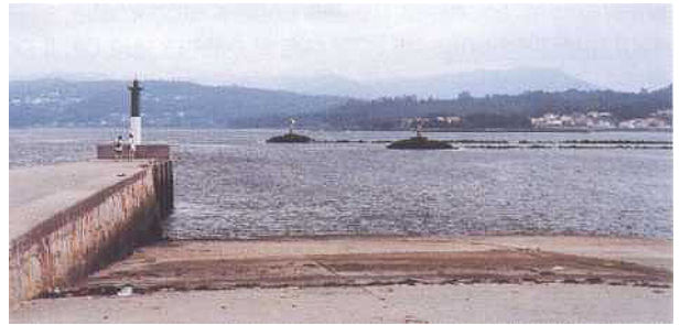
L'extrémité des deux digues de calibrage de Noya, vues depuis Punta Testai.
