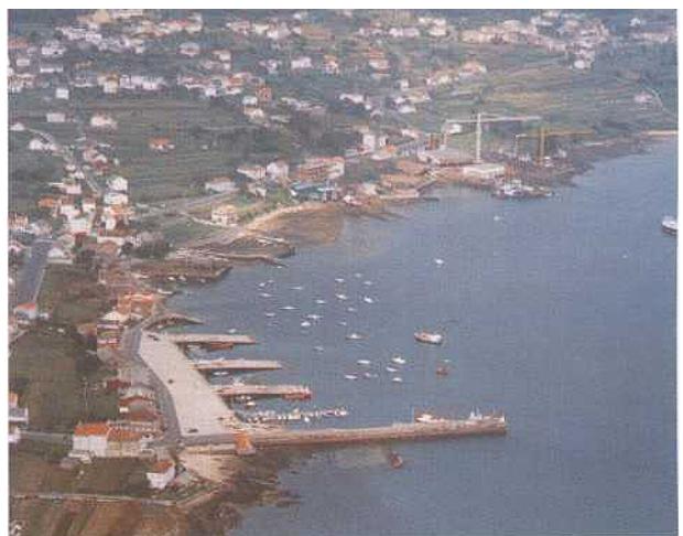
Le môle de Freijo vu du sud, avec le chantier naval - et ses deux grosses grues - à l'arrière plan.
