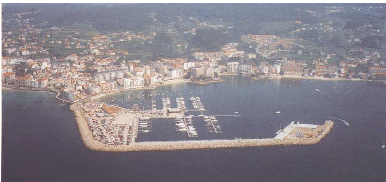
Portomar Sangenjo vu du sud en septembre 1999, avant la fin des travaux. Quand le port sera complètement achevé, il pourra accueillir environ 700 yachts.
