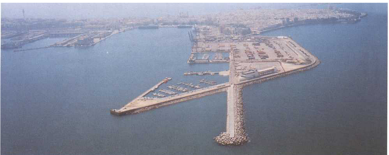
La large entrée du port de commerce de Cadix, avec la marina « Punta America ». La raison d'être du nouveau brise-lames, au premier plan, n'est pas encore très claire.
