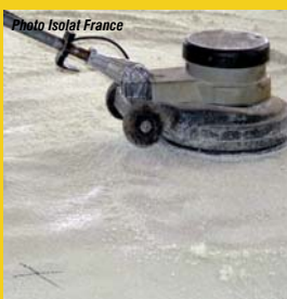
Photo Isolat France Ponçage de la mousse PU jusqu'à réapparition des marques de niveau.
