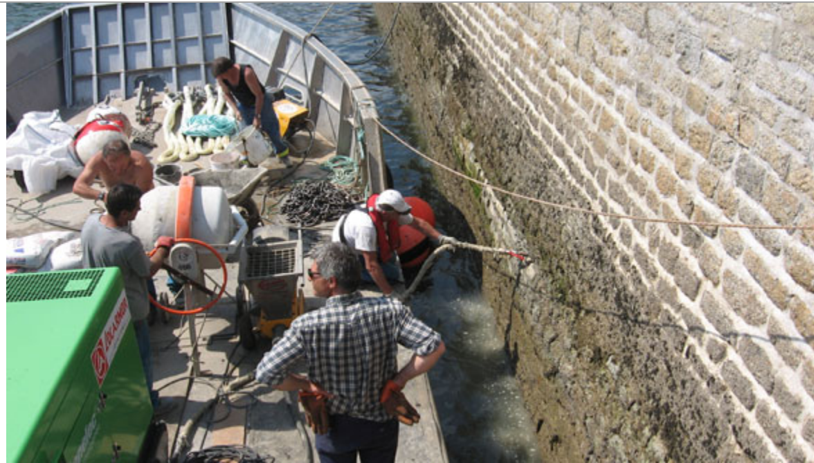
Jetée de Lomener: Rejointoiment de parement par mortier injecté sous pression Assistance to civil works
