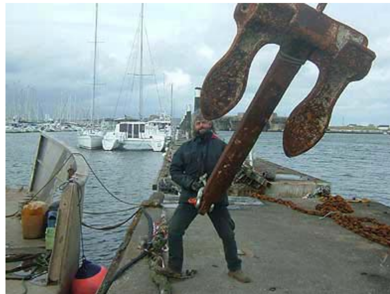
Remise en service d'un ponton brise-clapot lourd sur 4 ancrs d'1T5 après rupture du pieu Handling of harbour equipments.
