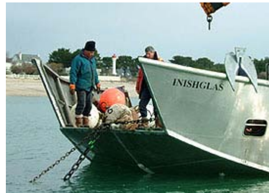
POSE DE CHAINE TRAVERSIERE
