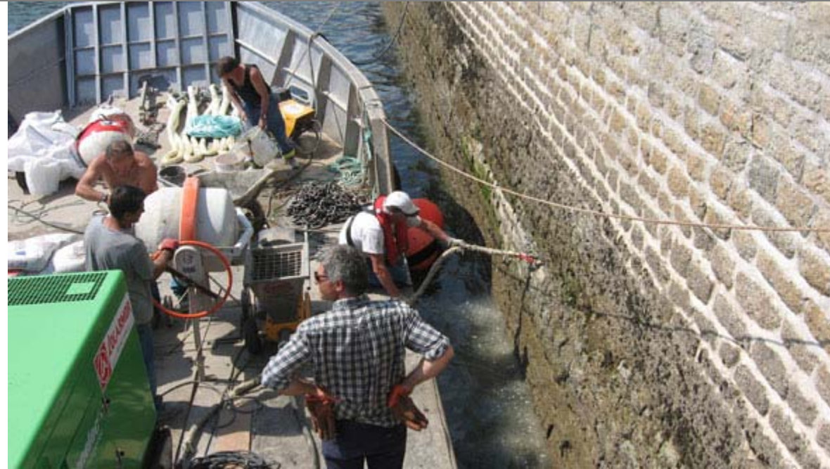
Jetée de Lomener : Rejointoiement de parement par mortier injecté sous pression Assistance to civil works
