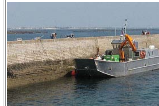
ASSISTANCE ENTREPRISES DE GENIE CIVIL
