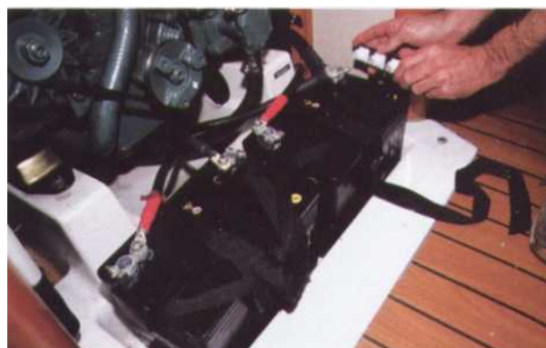
1 Le contrôle du niveau de l'électrolyte est un contrôle fastidieux mais nécessaire, l'électrolyte s'évaporant pendant les cycles de charge et de décharge de la batterie.
