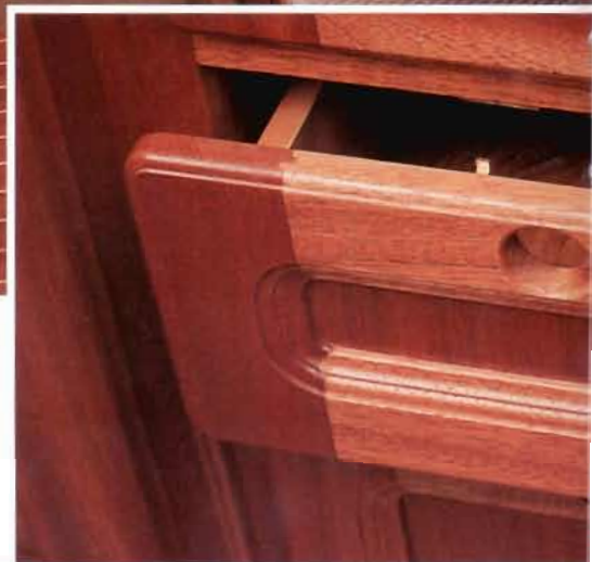
Formverleimungen und massive Blenden. Integrierte Griffe und Handläufe geben Sicherheit. Forms glued up and massive boardings. Integrated handles and accommodation rails perform safety.
