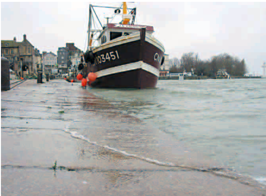
Le « quai de la Quarantaine » dépassé à Honfleur le 17 décembre 2004 en raison d'une forte surcote s'additionnant à une marée de coefficient pourtant relativement faible (71). (Archive du quotidien Ouest France ).
