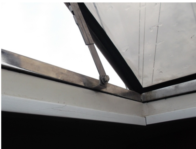
Sujeción de la carraca al marco inferior
