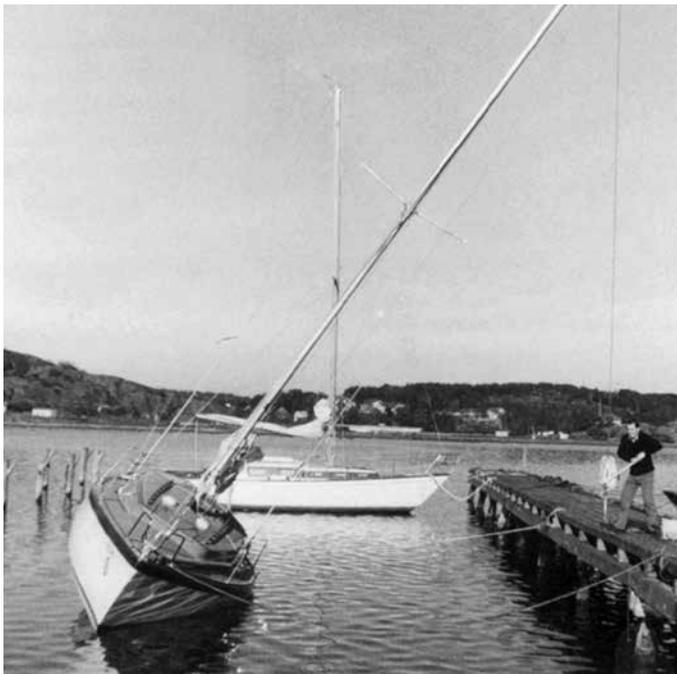
*Test de gîte en 1965. Le couple de redressement du bateau est mesuré avec un angle de gîte de 30°.*
