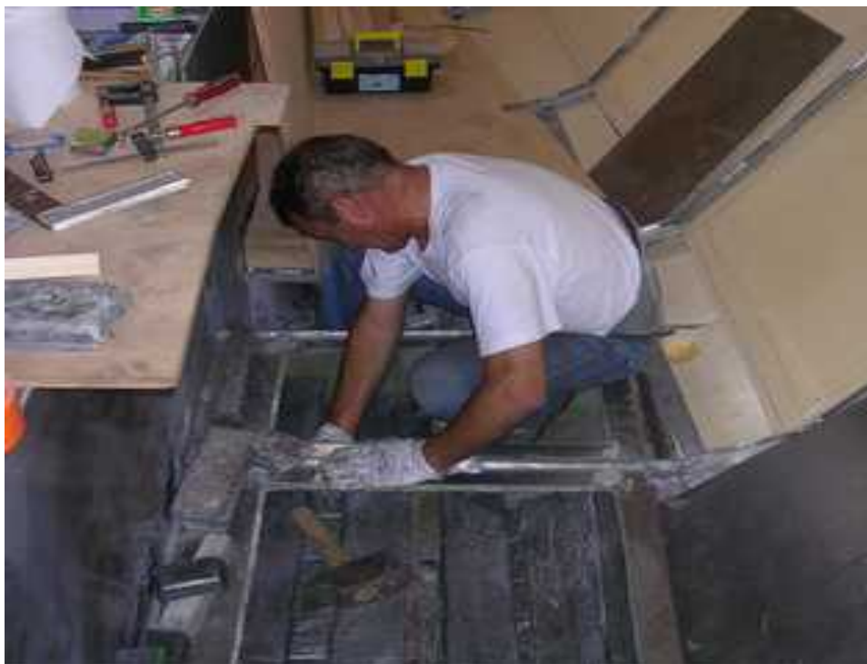
Mise en place des lingots de plomb dans les bacs dédiés.
