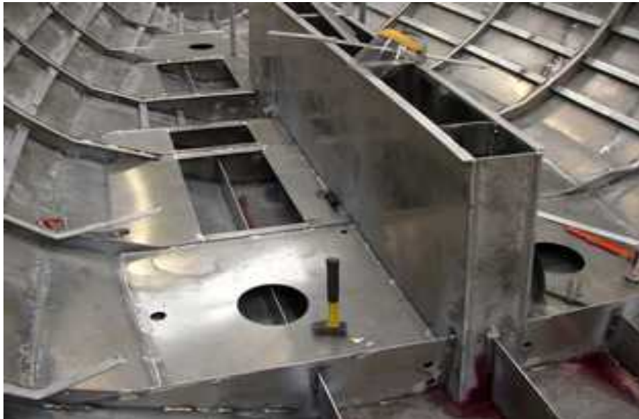
Les fonds de CROZET - plans de Jean-François ANDRE Réservoirs GO et bacs à plomb.
