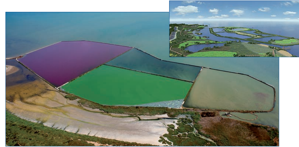
En haut : les anciens bassins de lagunage des eaux usées de Nador, en dessous : bassins dépollués, photo Jalal Lika.
