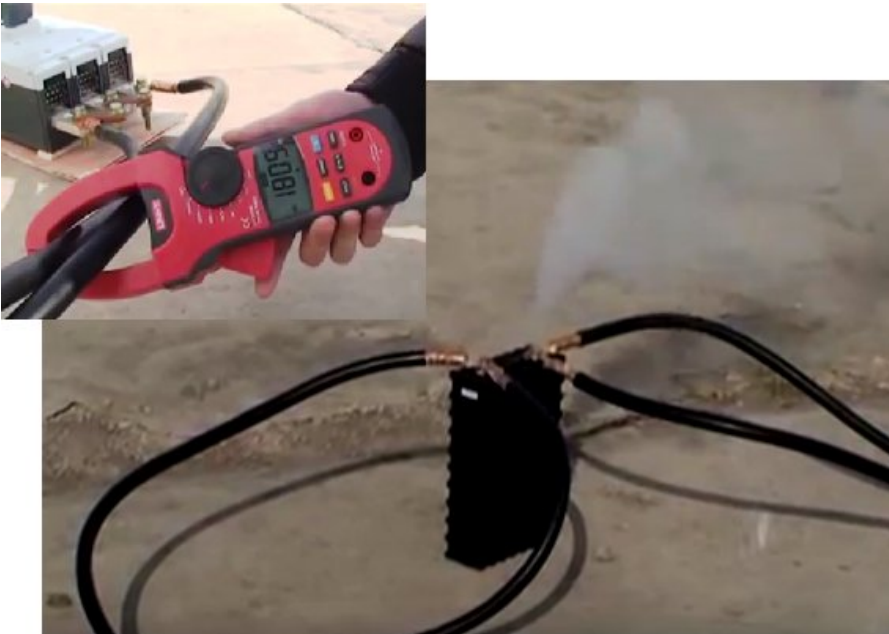
Un test de court-circuit sur une cellule Sinopoly complètement chargée Le courant dépasse 1800 A car la cellule s'évacue abondamment.
